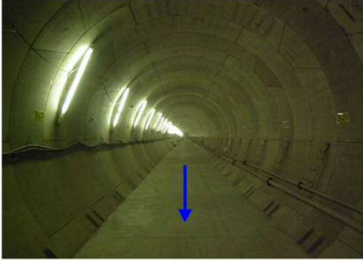
⑦青木川：放水路施工中
