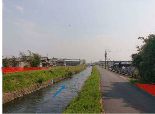
⑧合瀬川：用地補償及び河道整備
