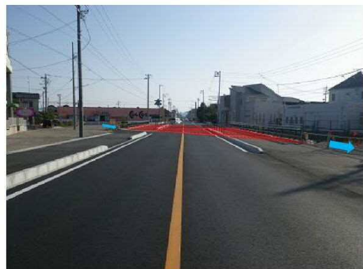
⑥青木川：橋梁改築
