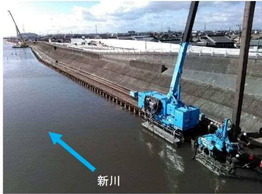
①新川：堤防耐震化
