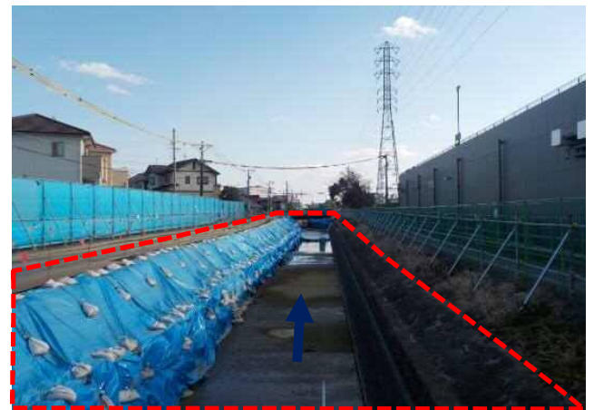
⑩薬師川：護岸工事
