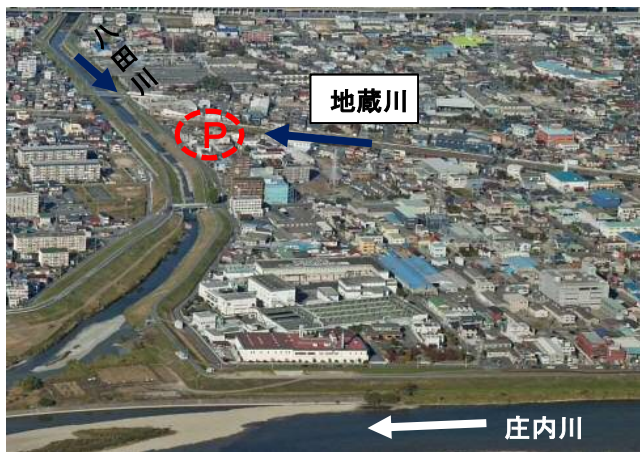
⑨地蔵川：排水機場建設予定箇所
