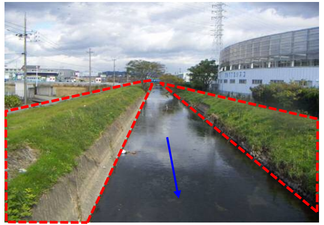
⑧合瀬川：今後の改修区間
