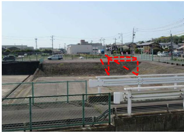
⑦青木川放水路
