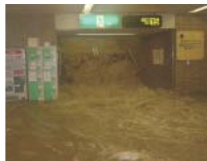
平成15年 福岡市の地下街浸水状況
