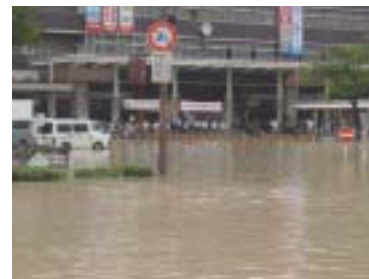
平成15年 福岡市内浸水状況
