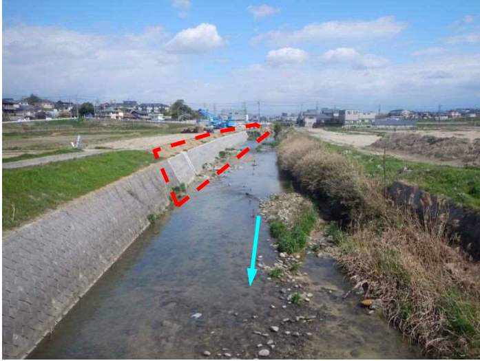
⑤逢妻男川： 護岸工
