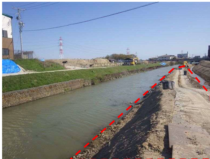
⑨五ヶ村川 背割堤（中堤）撤去実施状況
