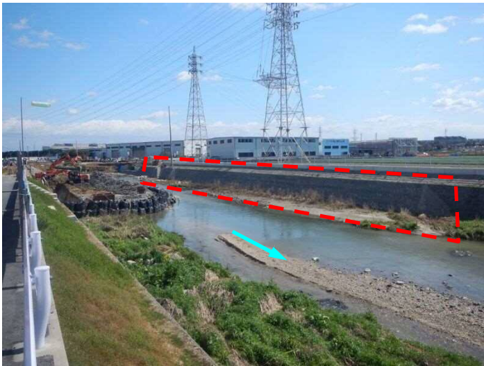
⑦逢妻女川 護岸工実施状況
