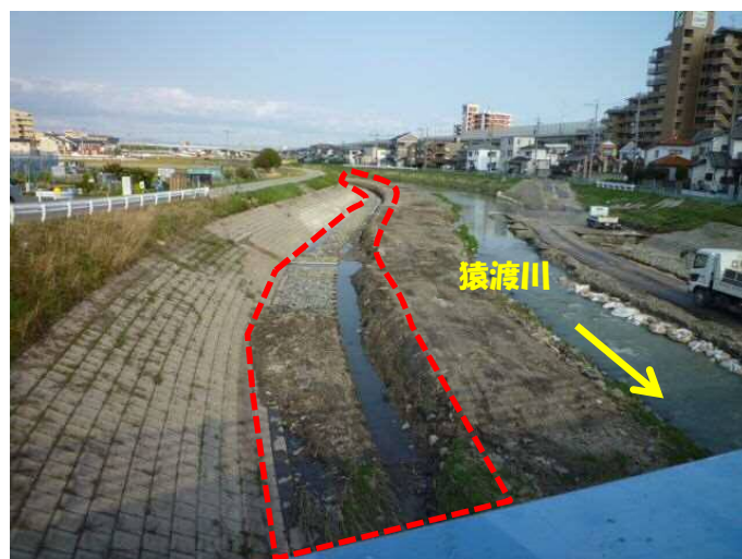
④猿渡川： 低水護岸工実施状況 （弘法橋上流部）
