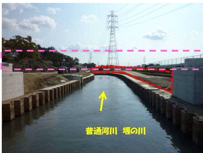
②逢妻川：洪水調節地 築堤工実施状況 人道橋実施状況（堰の川付替関連）
